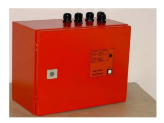
24 V DC – USV mit 4 getrennt ansteuerbaren Ausgängen im Schaltschrank IP54
